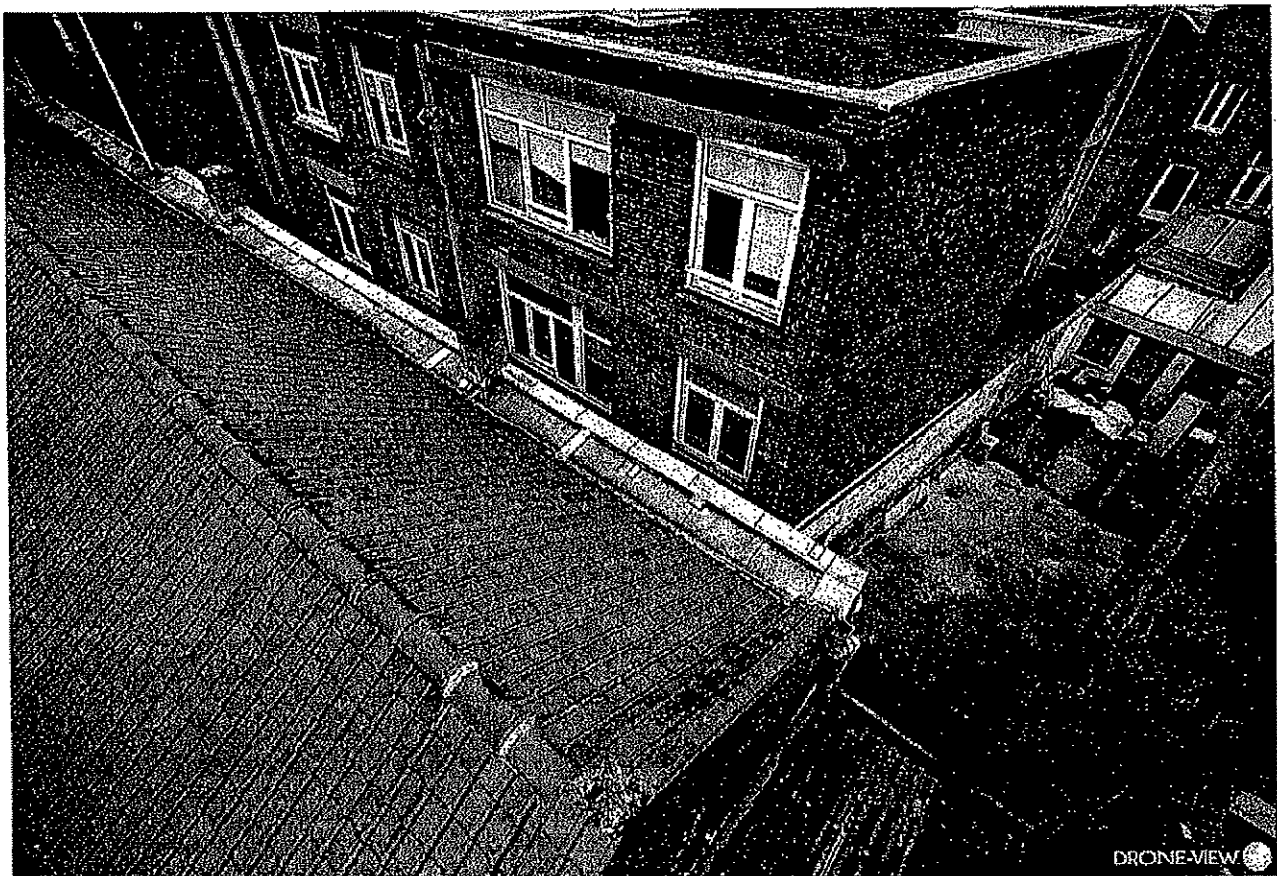
Photo aérienne via Drone View (Façades SO du Bâtiment C)
