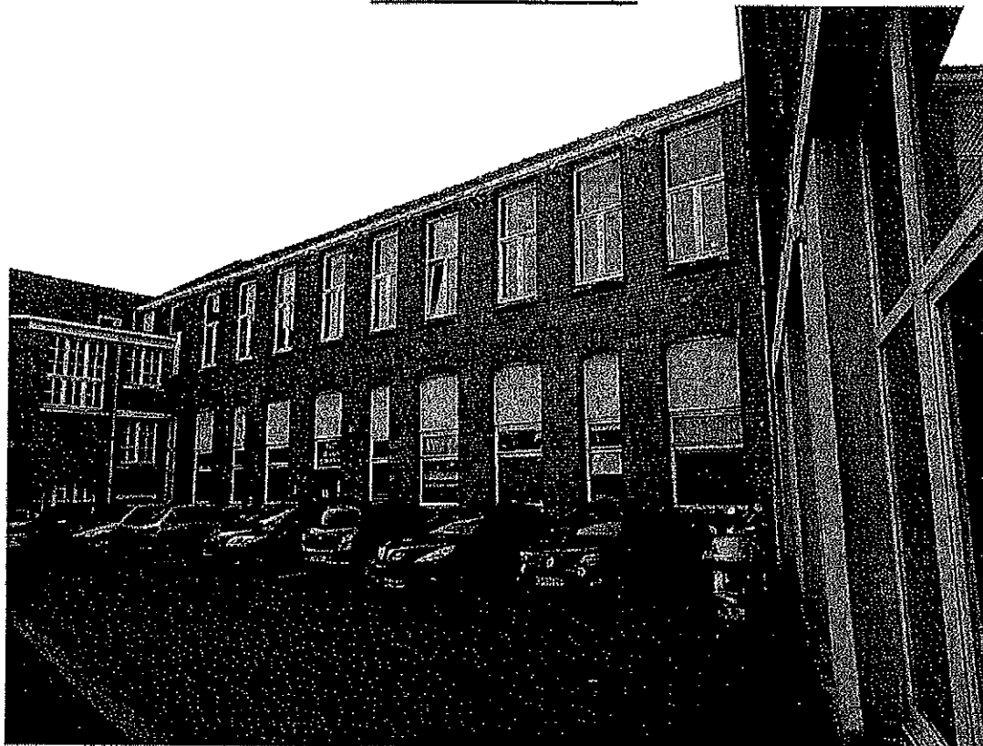
Photo 6 : Photo depuis la cour vers le bâtiment B
