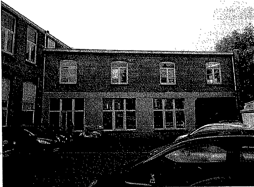
Photo 5 : Photo depuis la cour vers le bâtiment A
