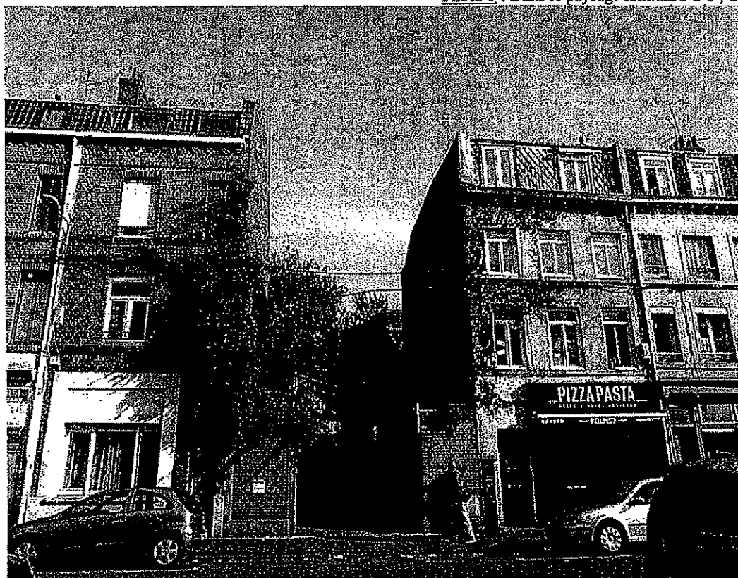
Photo 2 : Dans l'environnement proche PC 7 ; depuis la Rue des Postes
